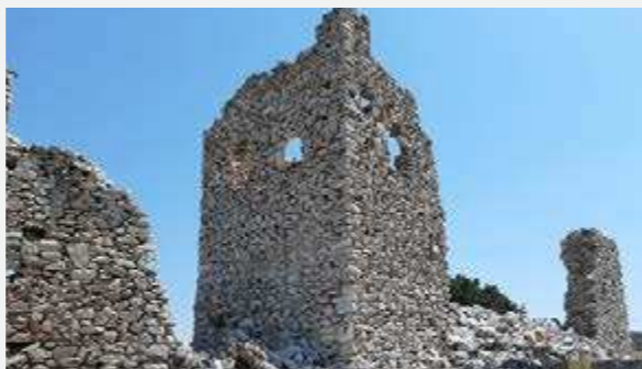
Εικόνα 3 Ριζόκαστρο Αλιβερίου, άποψη του πύργου στο εσωτερικό του κάστρου.
