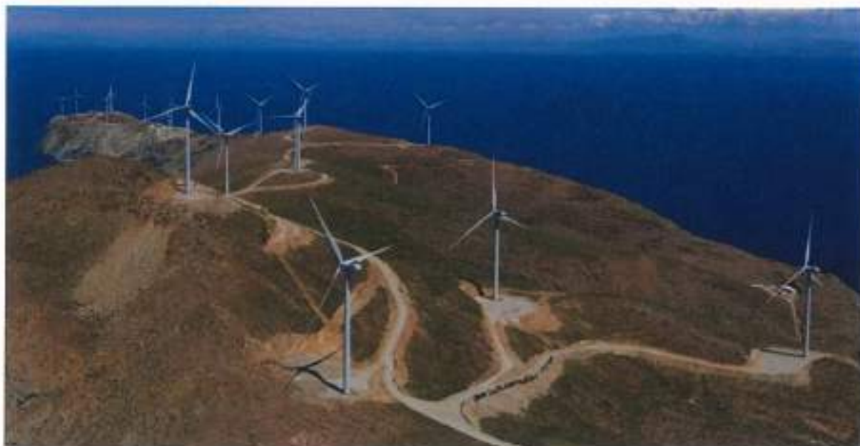
Εικόνα 35, Αιολικό Πάρκο και Υποσταθμός Ανύψωσης Τάσης, Νήσος Άγιος Γεώργιος
