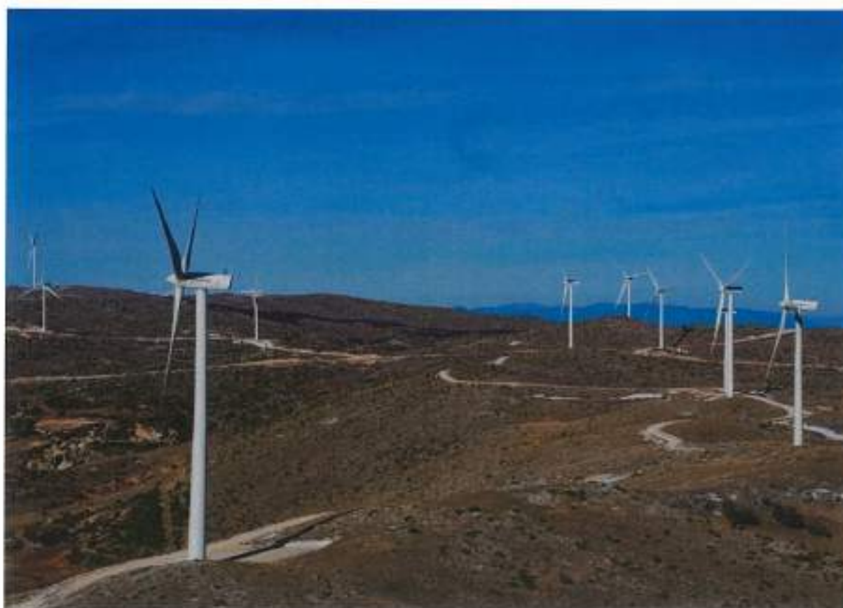
Πίνακας 198, Στοιχεία Αιολικό Πάρκο Ερεσσός - Ύψωμα, Βέροια
