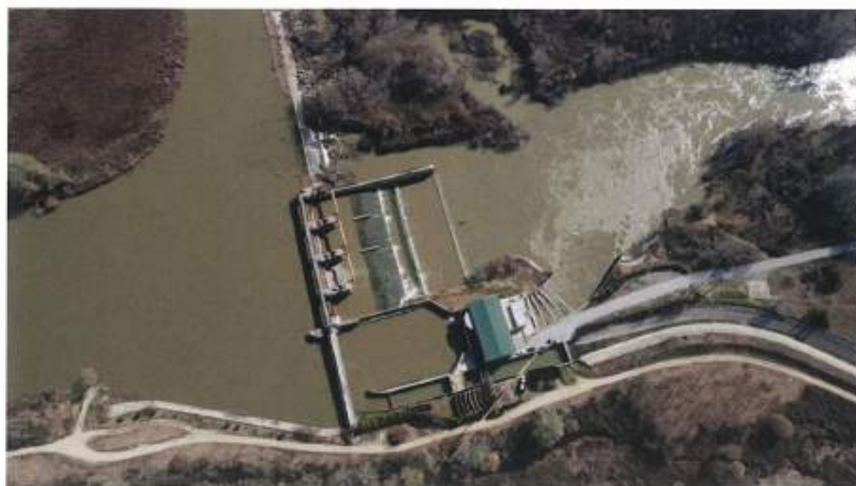
Εικόνα 15, Υδροηλεκτρικός Σταθμός Ελεούσας, Θεσσαλονίκη
