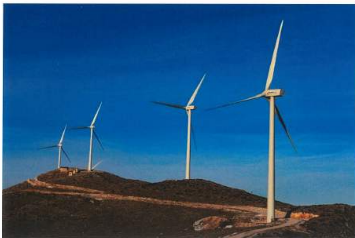
Εικόνα 32, ΕΝΕΡΓΕΙΑΚΗ Αιολικό Πάρκο Λεύκες - Κερασιά, Βέροια
