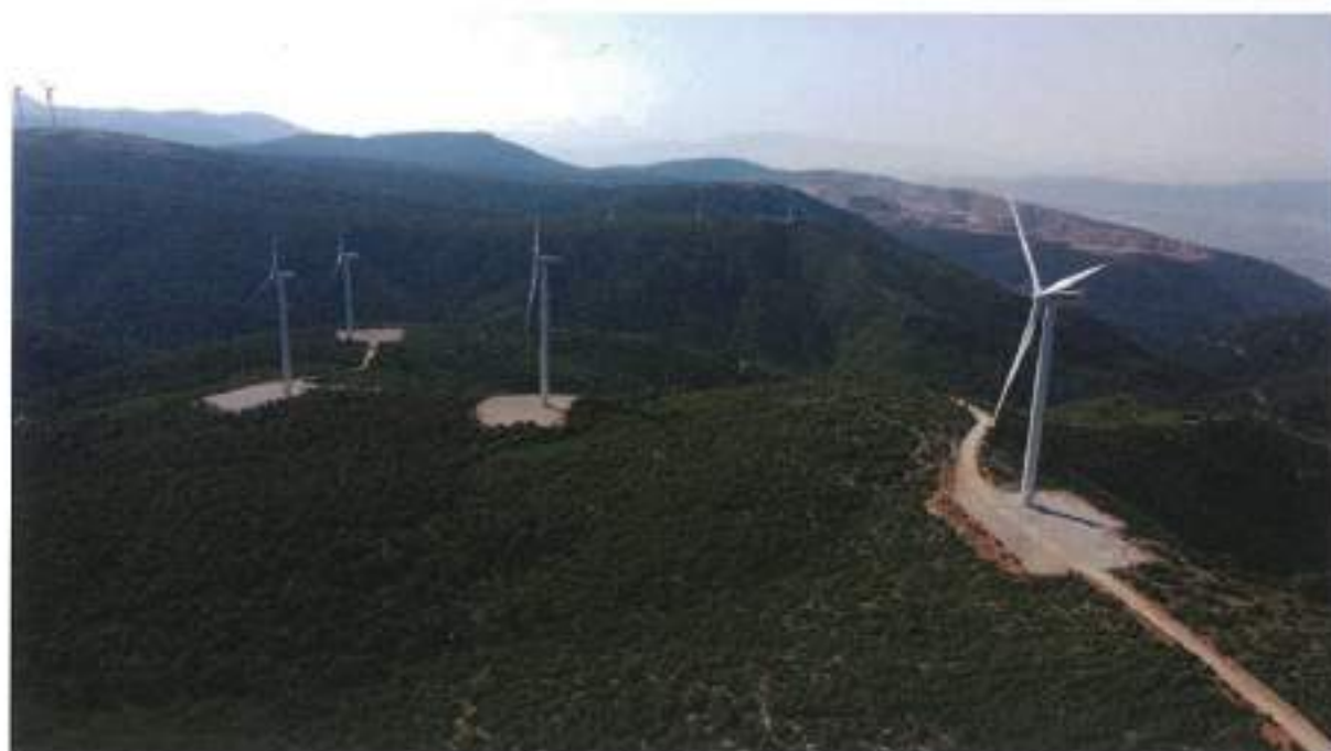
Εικόνα 22, Αιολικό Πάρκο Πλαγιά - Ψήλωμα, Βοιωτία
