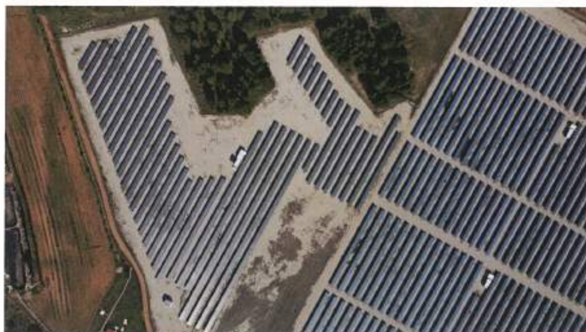
Εικόνα 20, Φωτοβολταϊκό Πάρκο, Βαθυχώρι II, Ψάθα, Αττική
