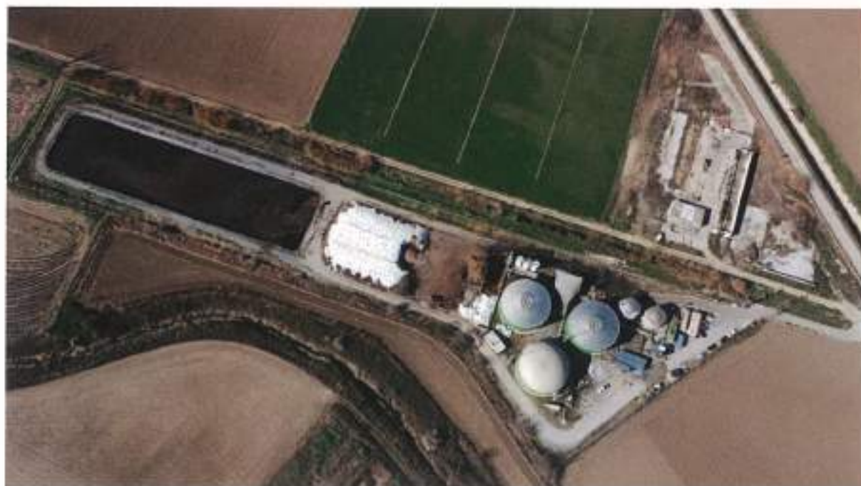
Εικόνα 14, Μονάδα Παραγωγής Βιοαερίου, Άδενδρο, Θεσσαλονίκη
