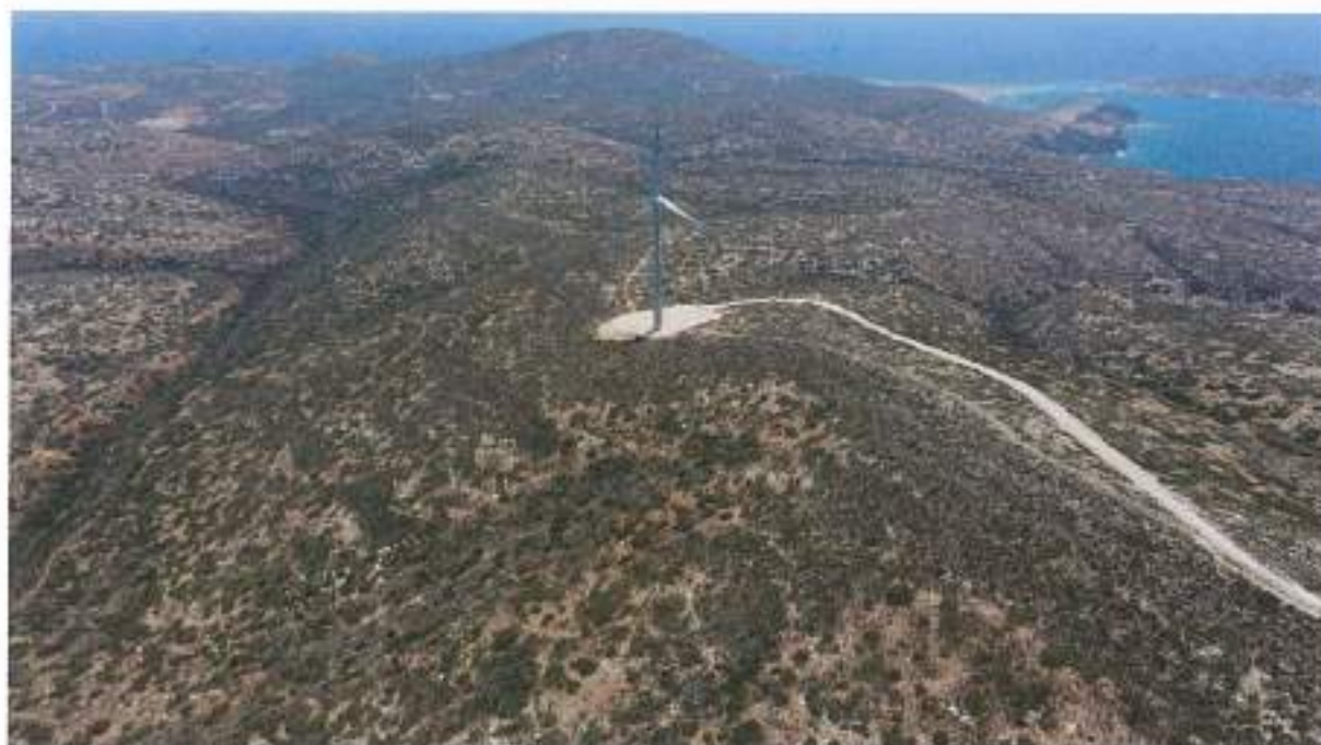
Εικόνα 33, Αιολικό Πάρκο Σταυρωτή, Ρόδος
