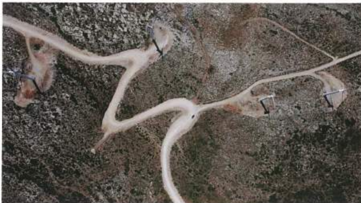
Εικόνα 8 Αιολικό Πάρκο Τσιλικόκα, Αλιβέρι Εύβοια
