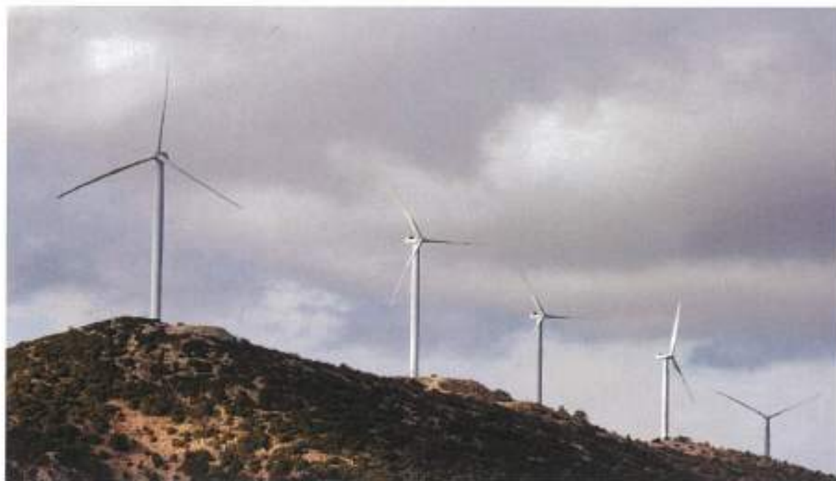
Εικόνα 5, Αιολικό Πάρκο Σκοπιά Ναύπακτος
