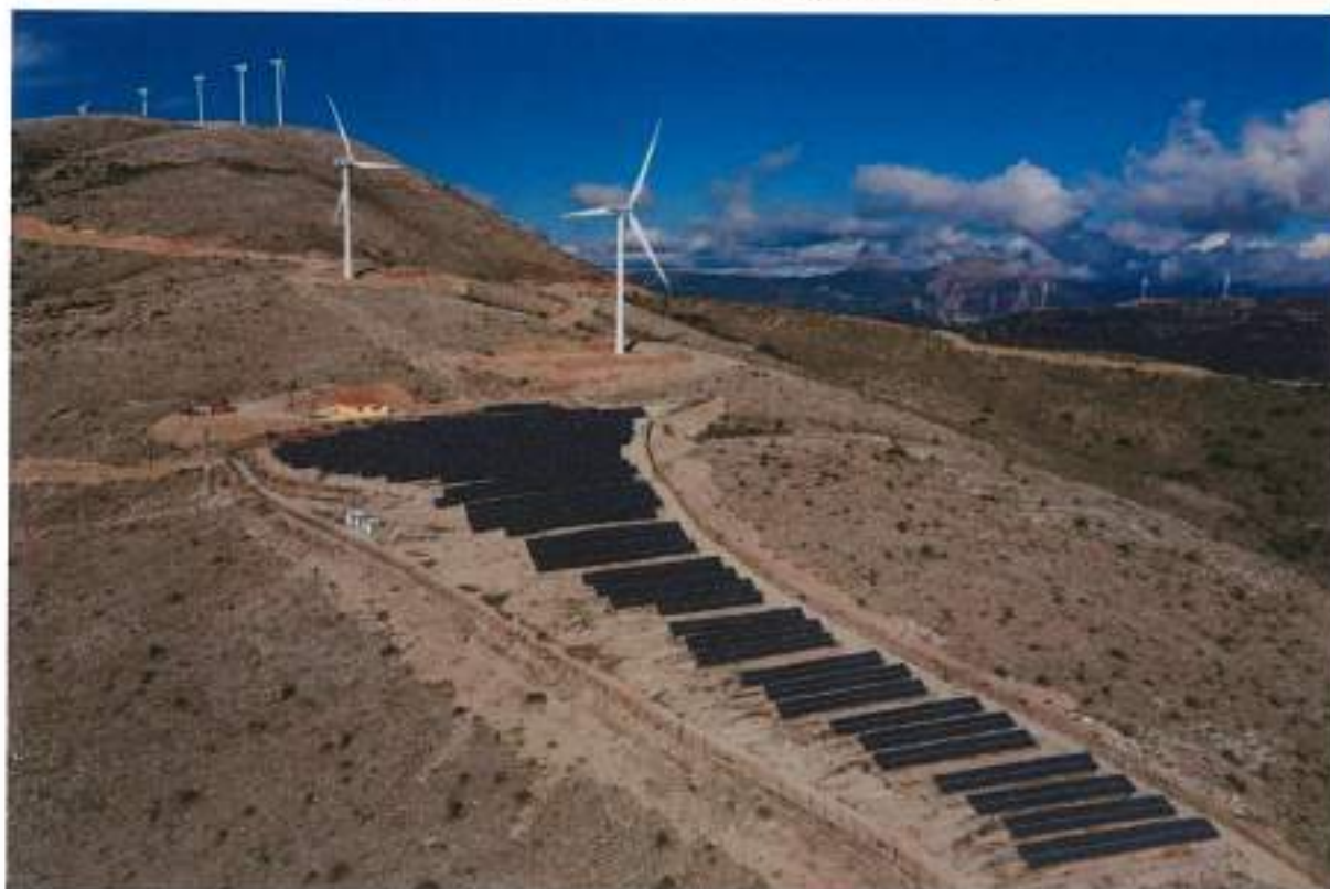
Εικόνα 12, Φωτοβολταϊκό Πάρκο Ναύπακτος
