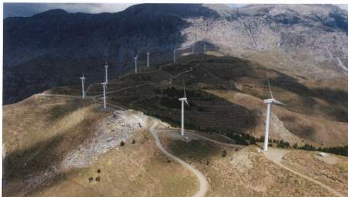
Εικόνα 11, Αιολικό Πάρκο Περδικοκορυφή, Κρήτη
