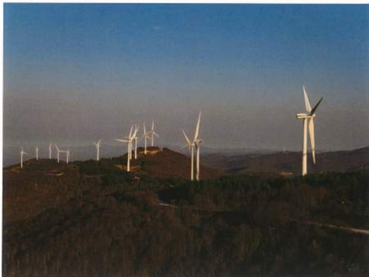
Εικόνα 26, Αιολικό Πάρκο Μυτούλα
